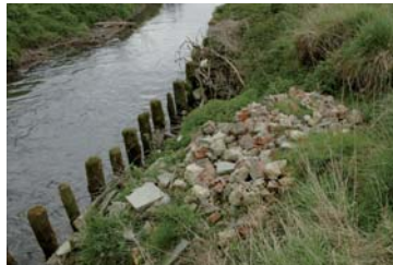
Dépôt de déchets inertes
